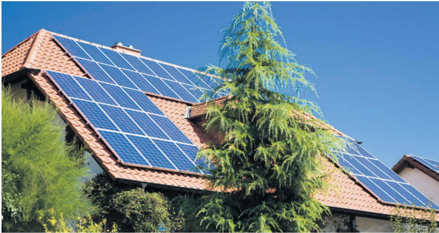
Der Nutzungsgrad einer Fotovoltaikanlage hängt von der geografischen Ausrichtung und der Neigung des Daches ab.
