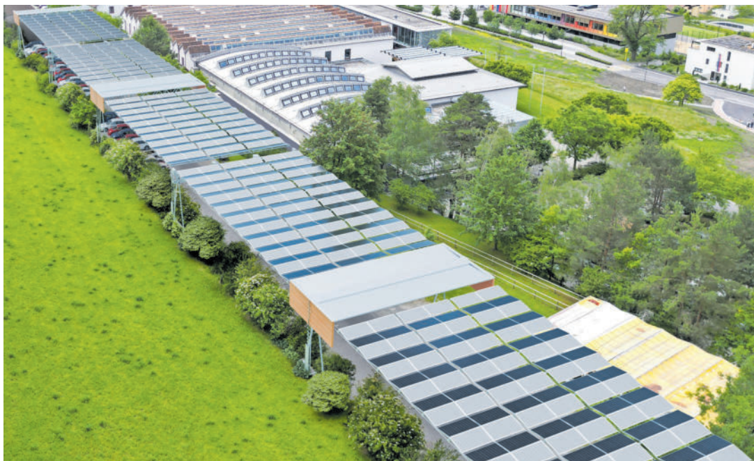
Im Dezember soll mit der Errichtung der Solarfaltdächer am Fabrikweg Spoerry in Vaduz begonnen werden.
