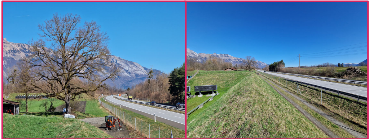
Abbildung 20: Blick nach Norden mit Böschung Schiessplatz
