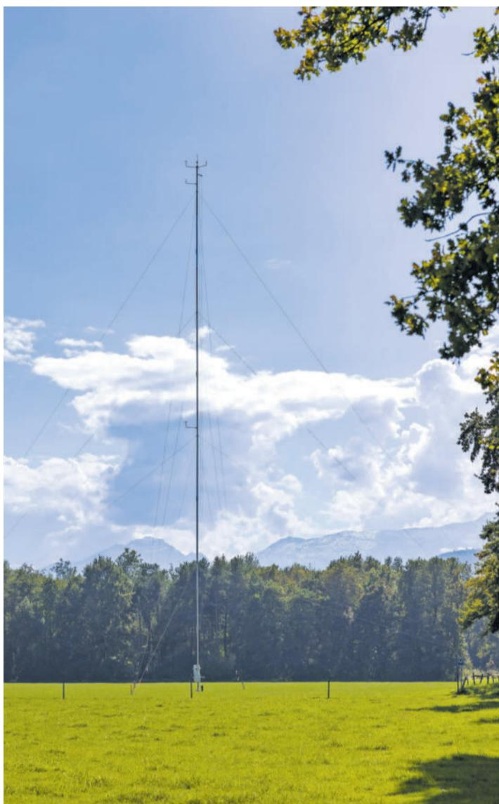
Der Windmessmast im Schaaner Riet wird 12 bis 18 Monaten lang Windgeschwindigkeiten aufzeichnen. Bild: Daniel Schwendener
