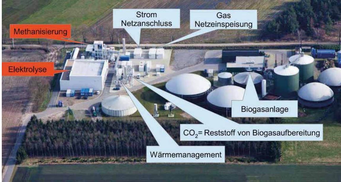
Power-to-Gas-Anlage Werlte (Quelle: ETOGAS, Audi)
