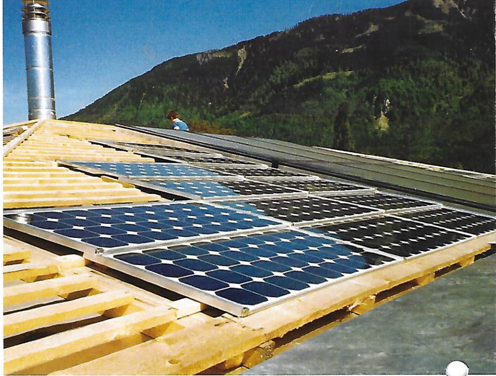
Montage der 3 kW-Photovoltaikanlage der Familie Lampert, Mauren. Die Anlage wurde durch das Impulsprogramm der Solargenossenschaft gefördert.
