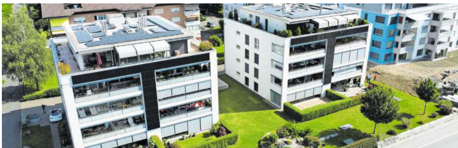
Die Anlagen am Frohwegpark haben eine Leistung von rund 60 Kilowattstunden.
