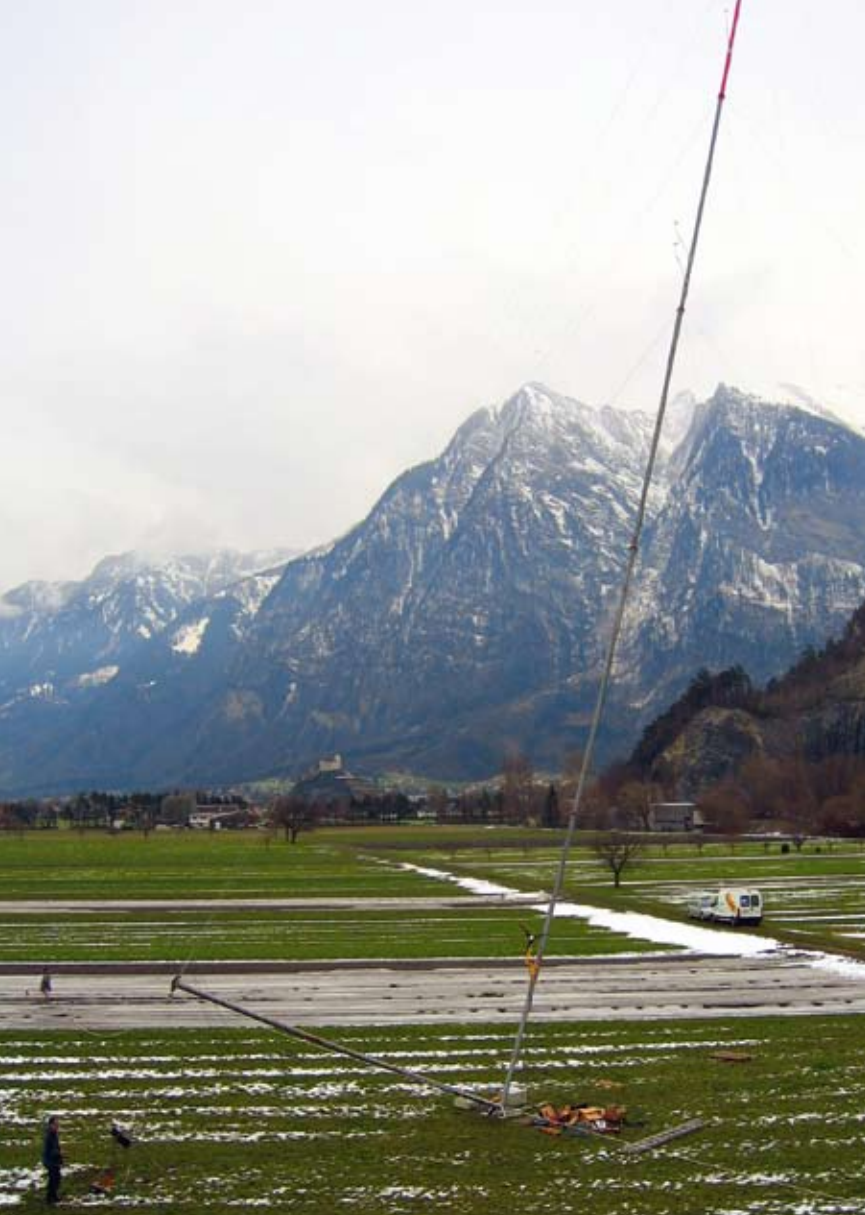
Wind-Messmast in Balzers wird auf- gerichtet
