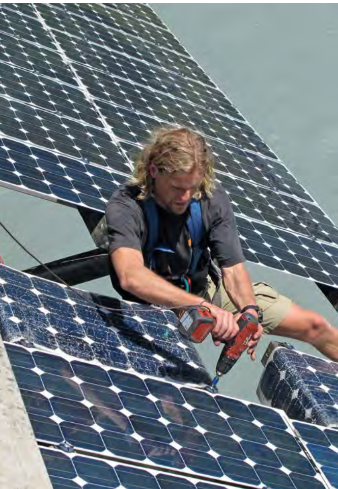
Vorstandsmitglied Reto Schurte ersetzt ein zerbrochenes Solarmodul der PV-Anlage an der Rheinbrücke Vaduz – Sevelen.
