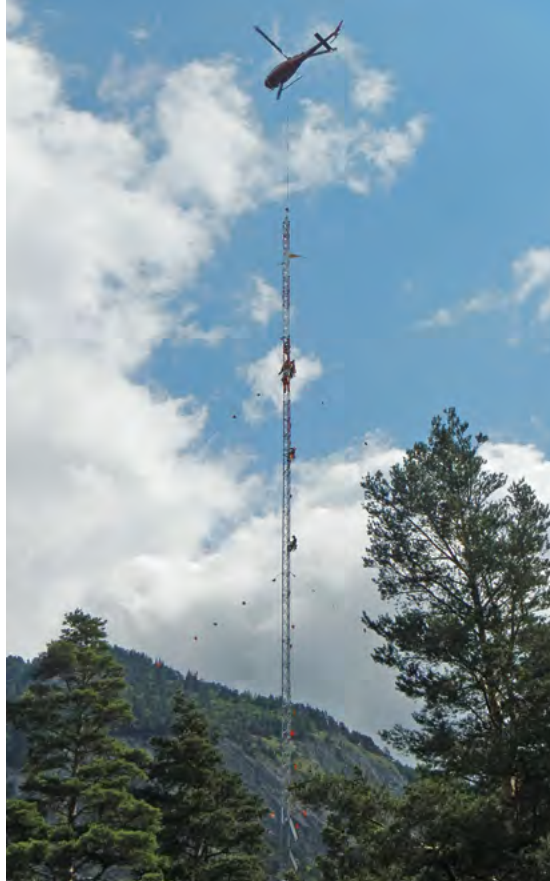
Montage des 99 Meter hohen Windmessmastens auf Ans durch spezialisierte Industriekletterer und mittels Einsatz eines Helikopters.
