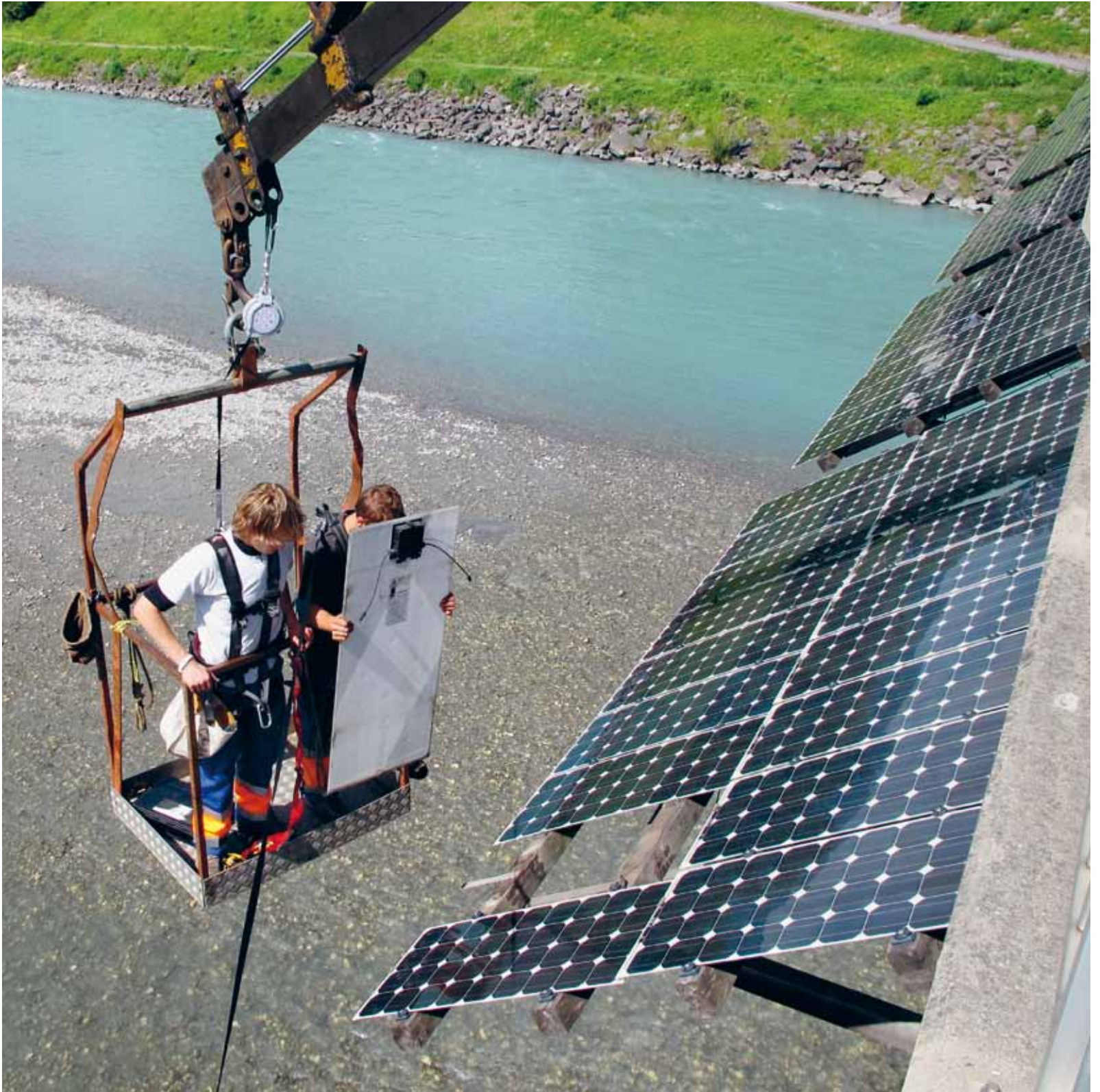
Defektes Solarmodul an der Rheinbrücke Vaduz wird ausgewechselt.
