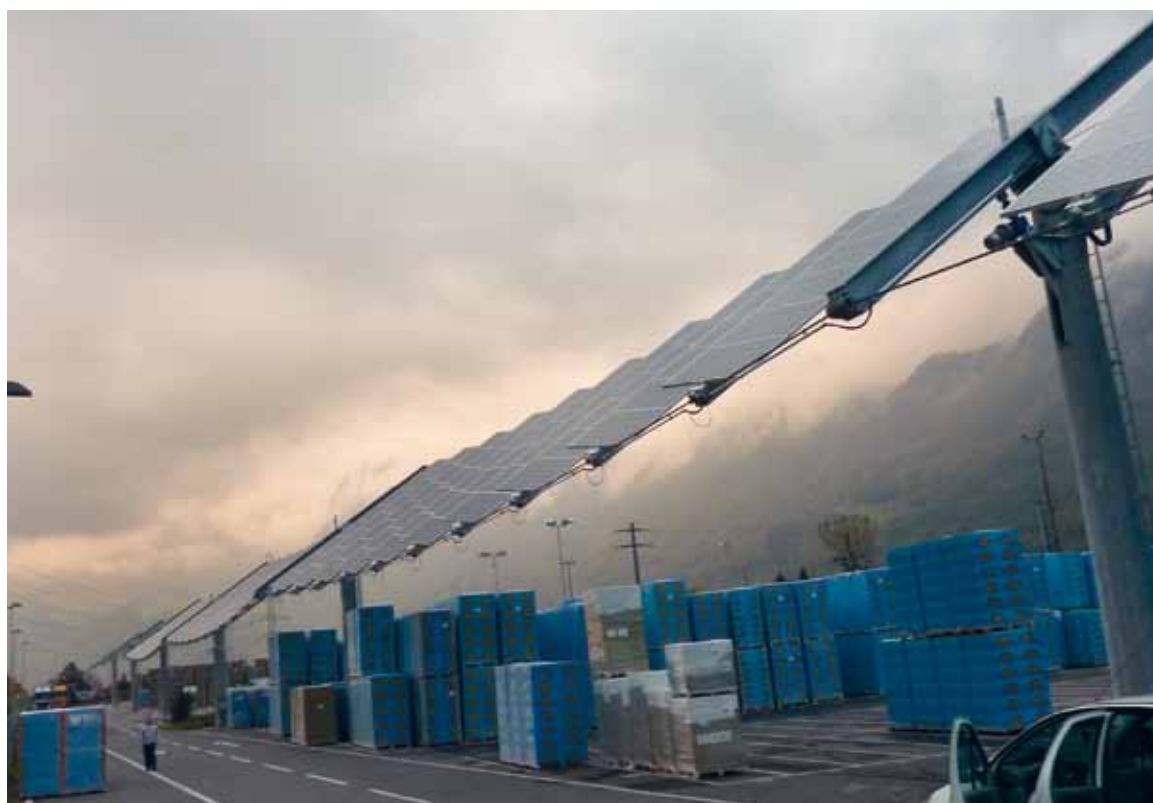
Solarwings-Anlage überspannt Flumroc- Areal
