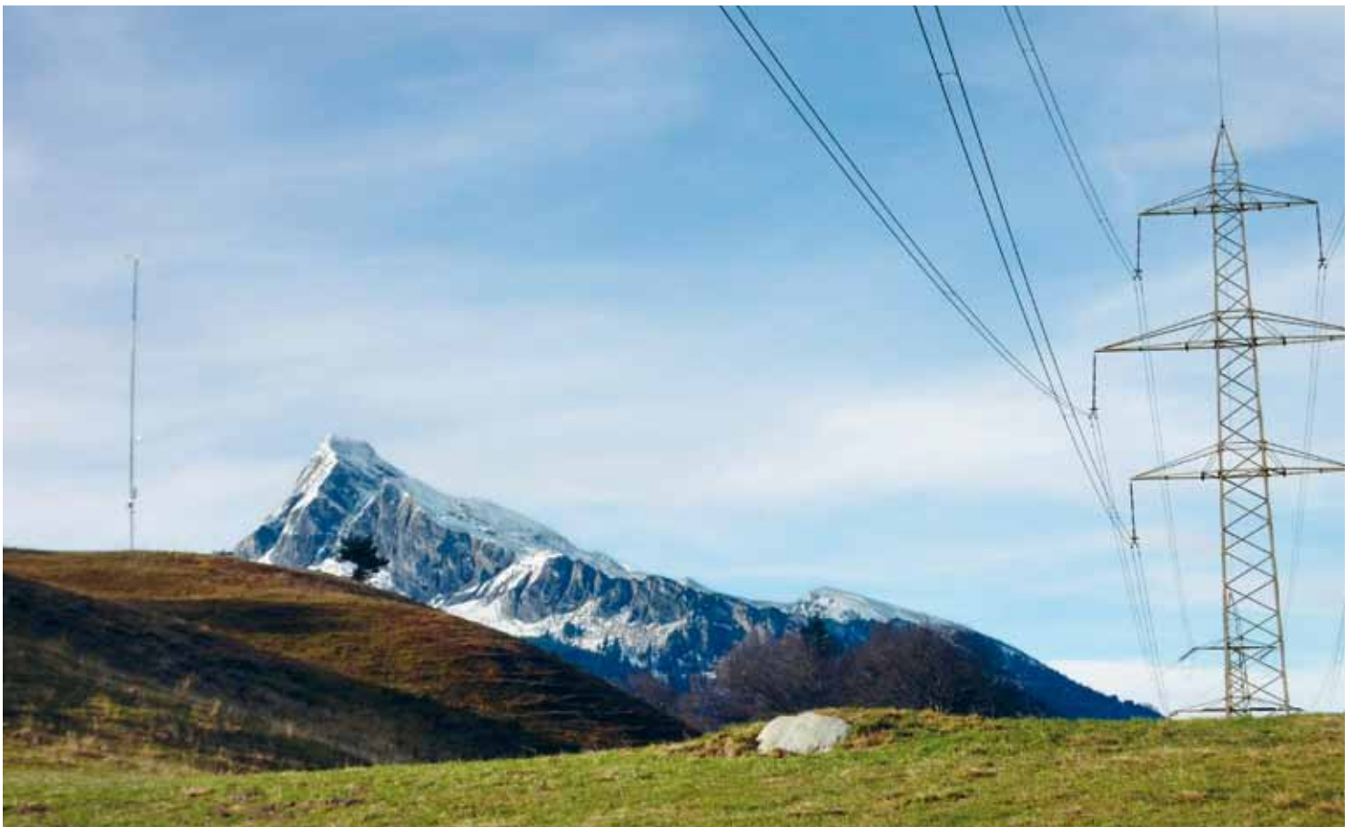
Windmessmast und NOK Stromleitung
